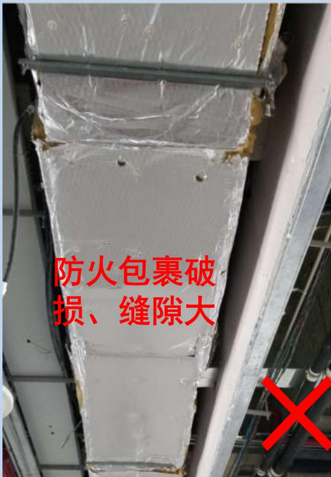
风管穿过防火隔墙、楼板和防火墙时，穿越处风管上的防火阀、排烟防火阀**两侧各2.0m范围内的风管应采用耐火风管或风管外壁应采取防火保护措施**，且耐火极限不应低于该防火分隔体的耐火极限。
