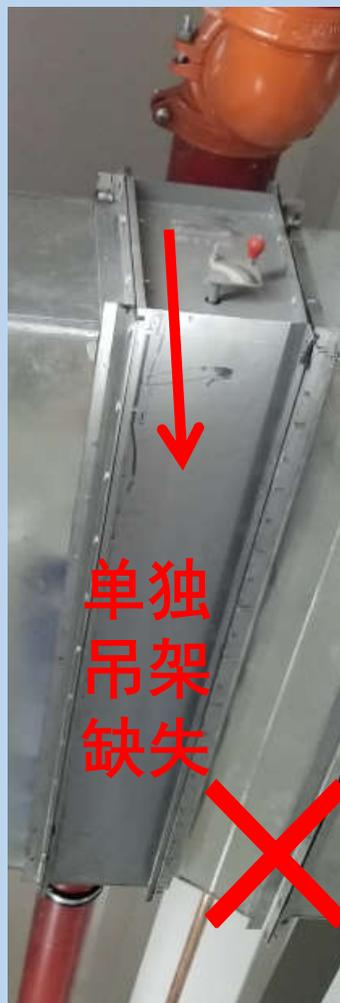
1. 防火分区隔墙两侧的**排烟防火阀**距墙断面不应大于200mm。
