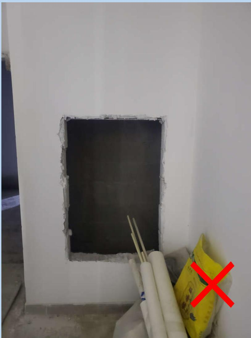
机械加压送风系统、排烟系统应采用管道送风、排烟，**不应采用土建风道。**
