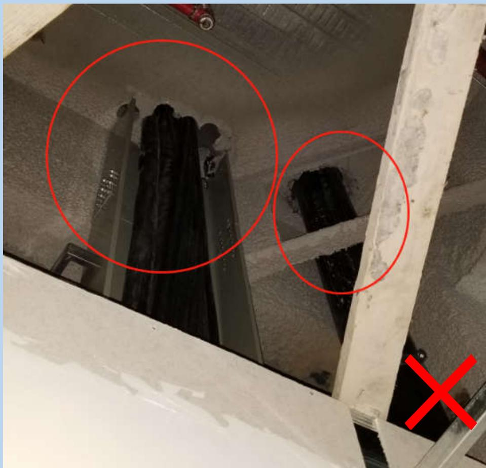
地下室管道穿防火隔墙未封堵
