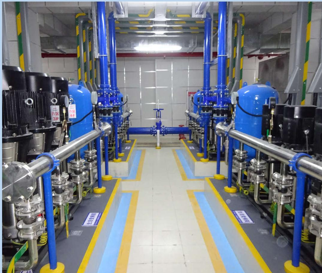
**通风与空调：冷冻机房管道设备布局合理，设备管道保温严密、标识清晰，减震降噪良好。**
