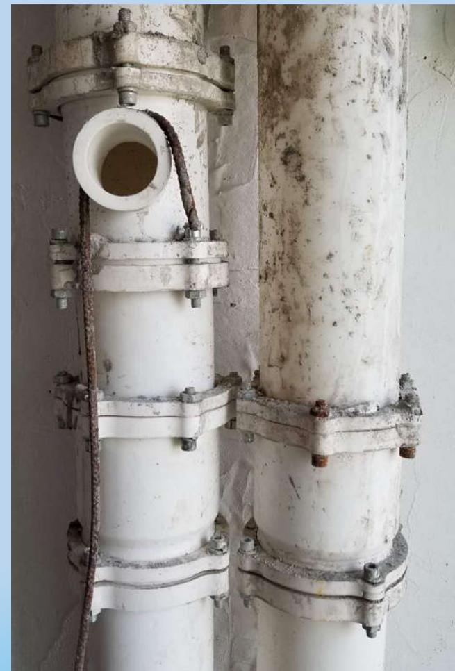
镀锌钢管**壁厚**严格执行《低压流体输送用焊接钢管》GB/T3091，壁厚的允许偏差为10%
